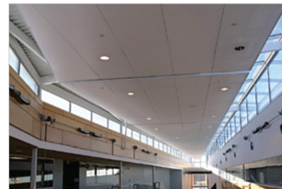
CÔNG TRÌNH LẮP TRẦN HOOK-ON
