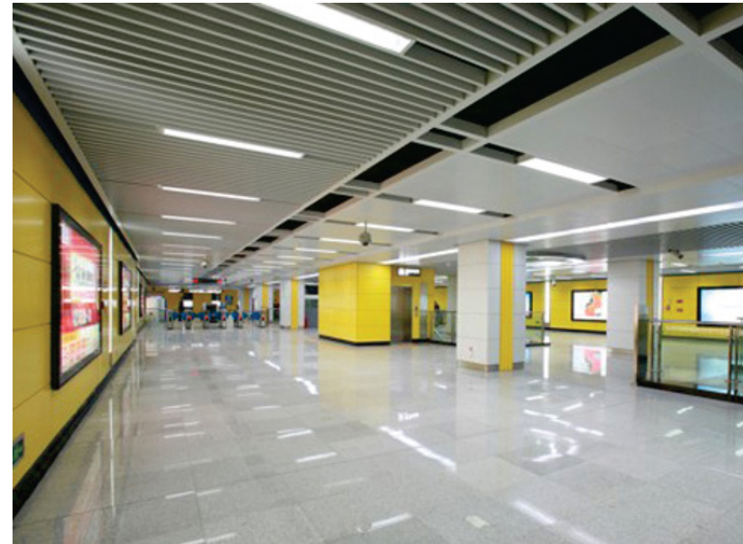
TRẦN U-SHAPED LẮP ĐẶT TẠI NHÀ GA
