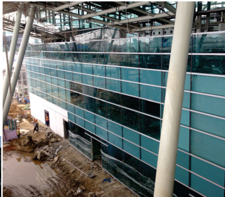
LẮP DỰNG MODULE KÍNH TẠI DỰ ÁN SẦY Y ĐÀ NẰNG
