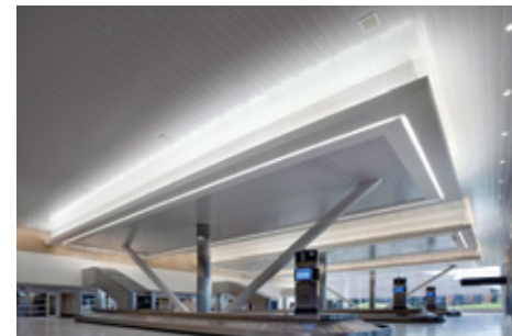
CÔNG TRÌNH LẮP ĐẶT TRẦN C300-SHAPED
