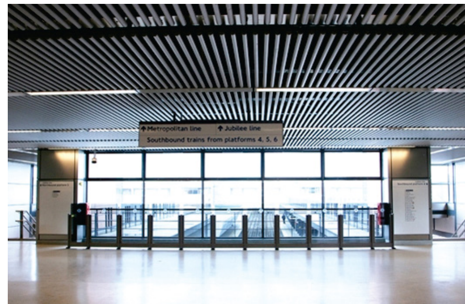
TRẦN ỐNG LẮP TẠI NHÀ GA
