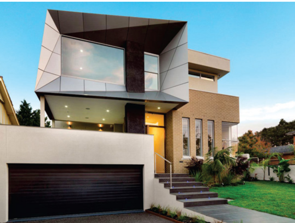
CÔNG TRÌNH ỐP TẤM NHÔM NHỰA
